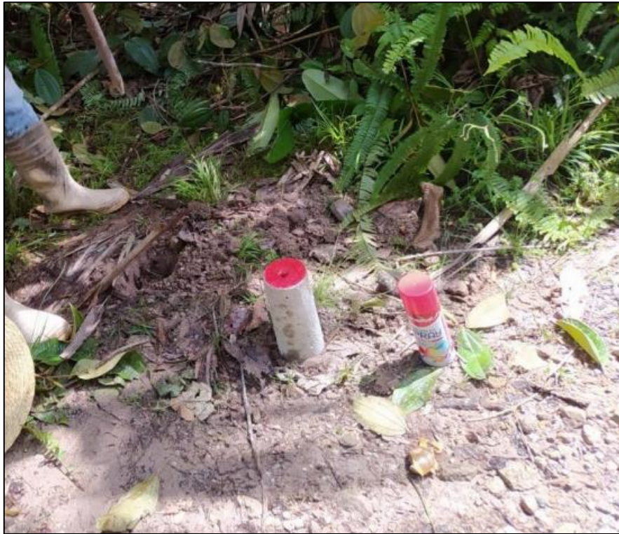
Figura 15. Mojón de concreto cilíndrico
