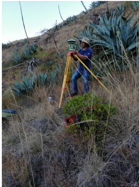
Figura 8. Replanteo de la ubicación de la red hidráulica
