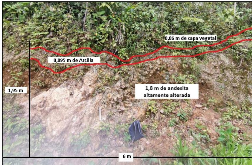
El área presenta una cobertura vegetal de 0,06 m de espesor y está totalmente húmeda. La litología consiste en una capa de 0,095 m de arcilla café marrón tipo suelo con partículas irregulares, seguida por 1.8 m de andesita altamente alterada, una roca relativamente blanda y porosa que es susceptible a la desintegración. Debido a la visibilidad de su composición mineral, se deduce que su textura es afanítica.
