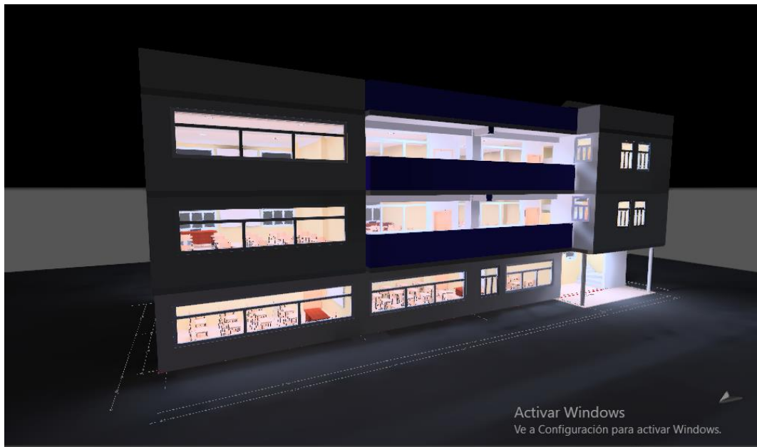
Figura 33. Edificación con la implementación de los paneles LED en todo el establecimiento
