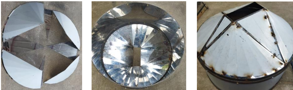
Figura 13. Soldado y Montaje del Cono de Transición
