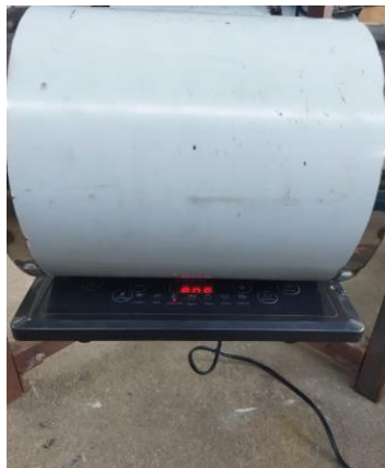
Figura 19. Montaje de la Cocina de Inducción
