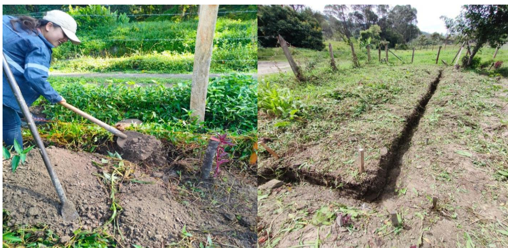
Figura 6. Excavación de las zanjas para la tubería principal y secundaria.
