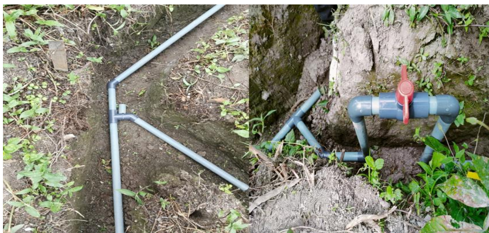
Figura 7. Instalación de la tubería principal y secundaria.
