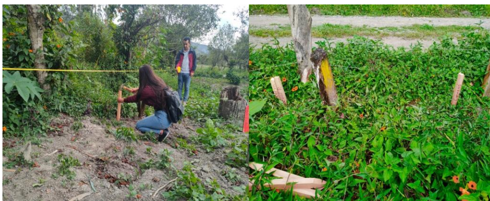
Figura 5. Replanteo de la tubería principal y secundaria.
