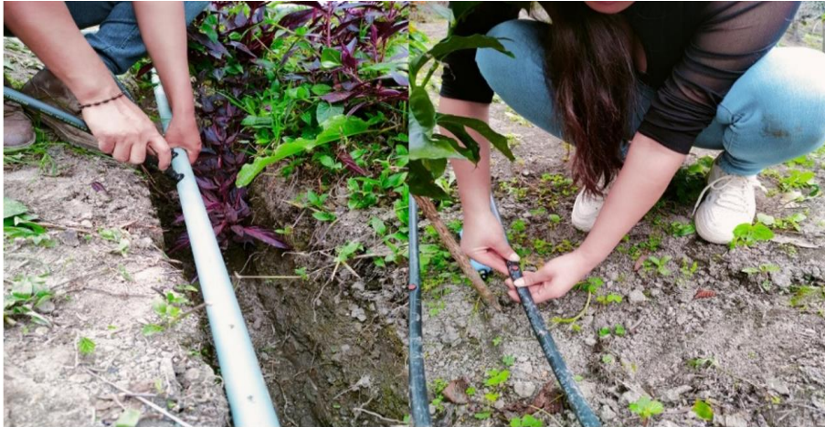
Figura 8. Instalación de los laterales y emisores de riego.
