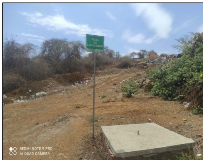
Figura 28. Sitio de drenaje de lixiviados y aguas lluvia
