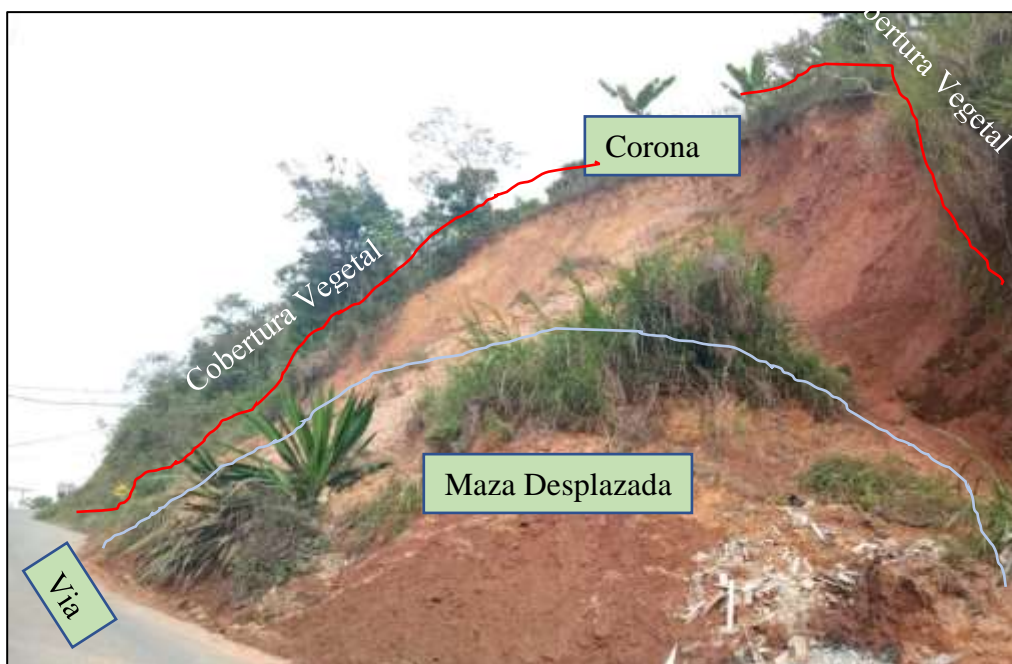
Figura 53 Deslizamiento (D1) ubicado en la absc 0+156
