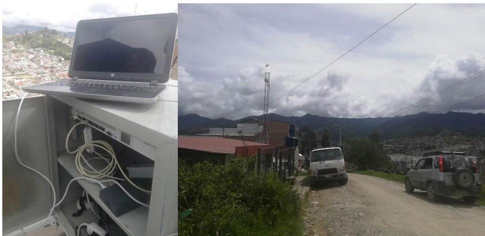
*Nota.* Figura propietaria del autor, esta caja de telecomunicaciones alberga acometida de energía, router administrable y cables de red, adicional se muestra lugar donde se configura la salida a internet del Gateway y se visualiza una vista de la torre de la antena junto con su zona de cobertura.
