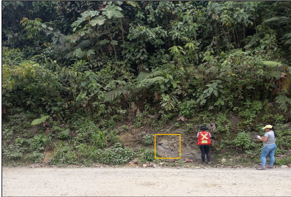
Figura. 47. Zonificación del talud N°1.
