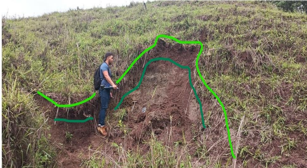
Figura 28 Afloramiento N.º A2. Arcillo limosas
