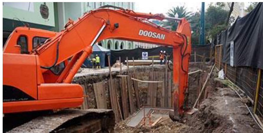
Figura 7. Excavación con maquinaria en el parque central de Loja.
