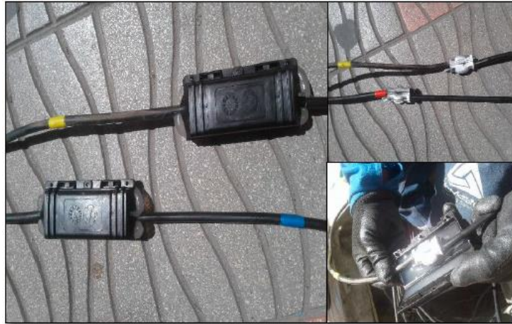
Figura 64. Empalme tipo gel para el alumbrado público.
