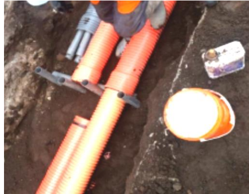
Figura 11. Conexión de tuberías de 160 mm.
