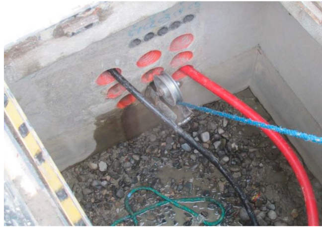
Figura 15. Pozo con orificios laterales terminados.
