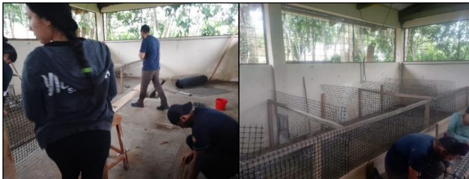
Figura 7. Construcción de los corrales
