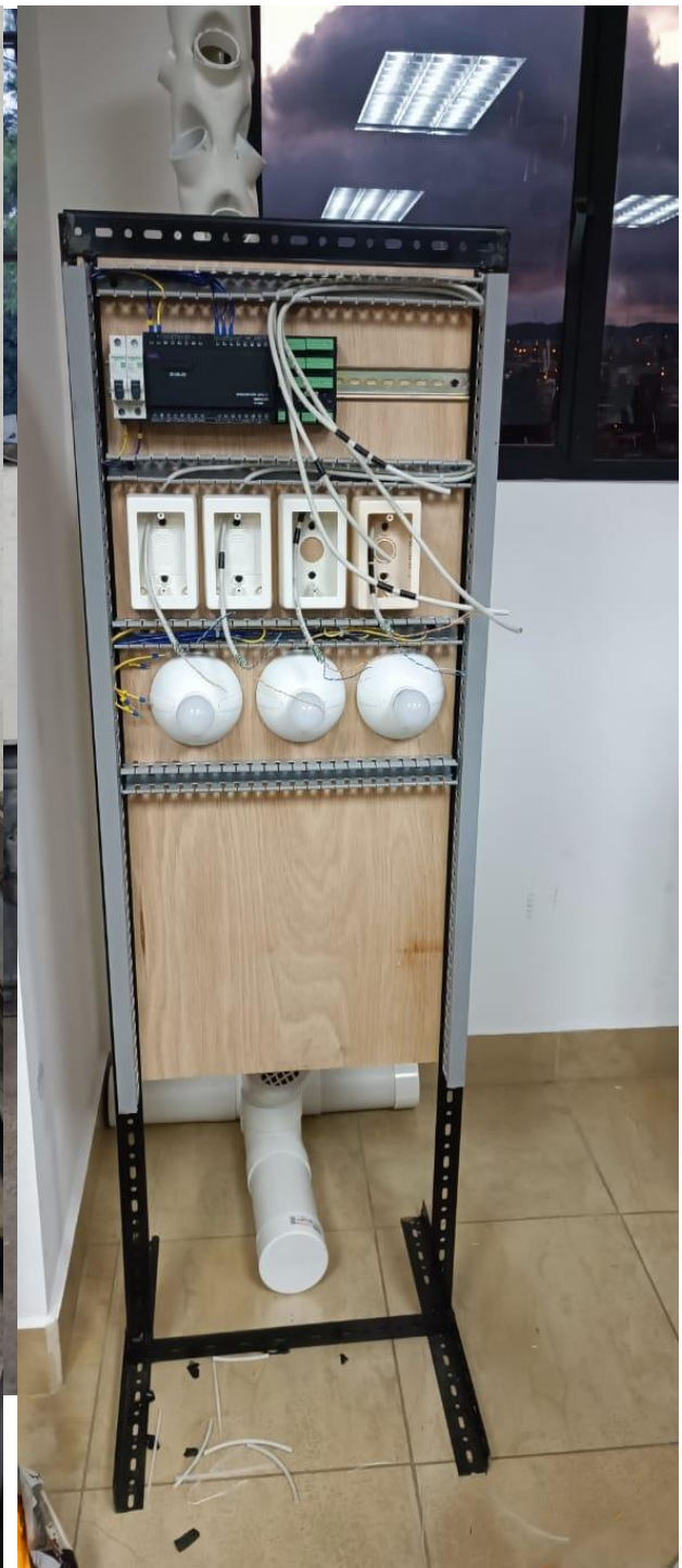
Figura 63. Instalación de accesorios y equipos eléctricos
