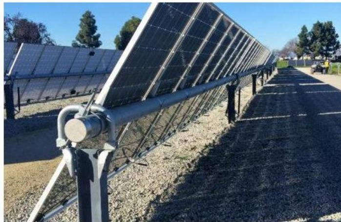
**Figura 4:** Planta solar con sistema de seguimiento de un eje.
