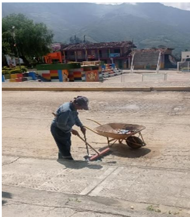
Figura 18. Barrido y limpieza.
