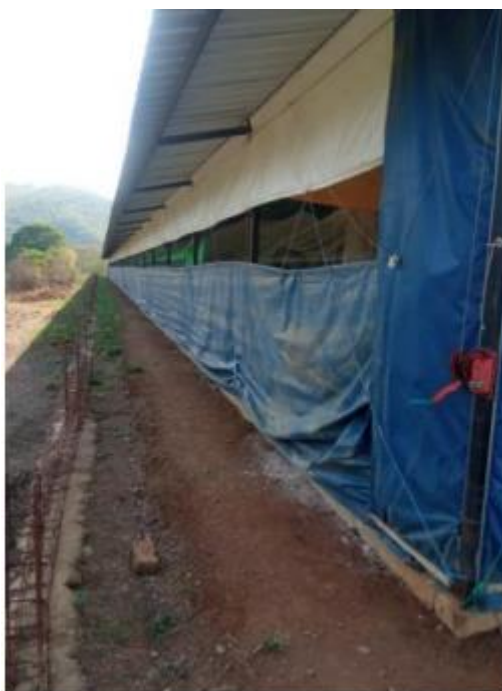
Figura 11. Sistema de apertura por malacate dentro del galpón “Avícola Lanzaca”.
