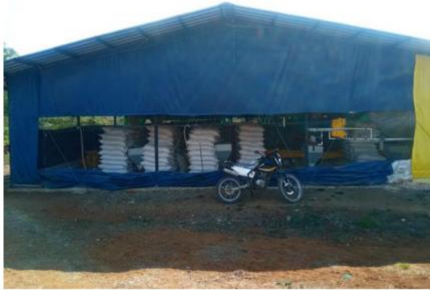
Figura 12. Estructura frontal del galpón avícola.
