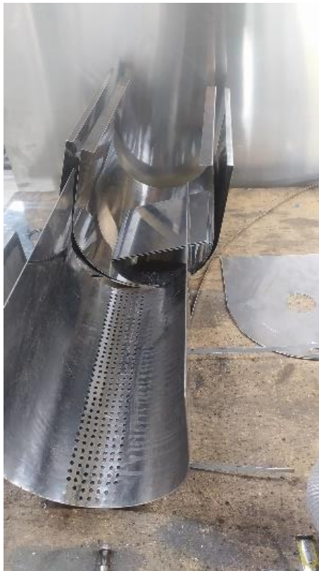
Figura 89. Planchas del depósito roladas.
