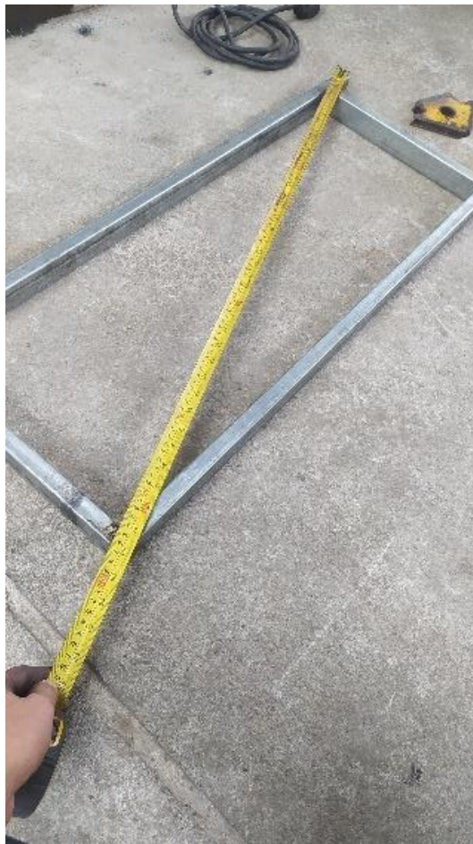
Figura 95. Construcción del bastidor.
