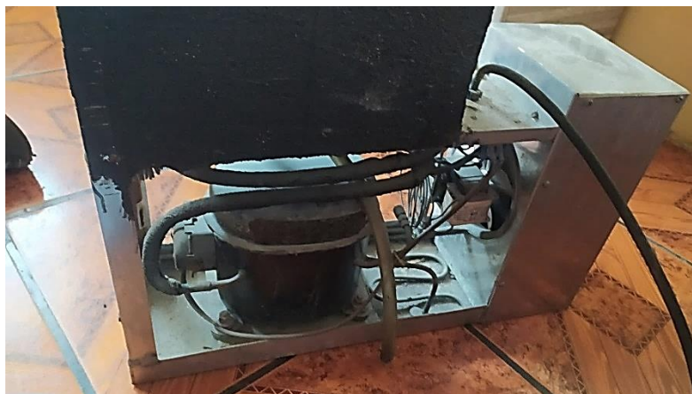
Figura 78. Torre de refrigeración.
