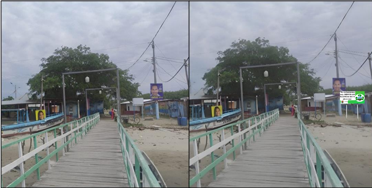
Figura 20. Montaje de valla publicitaria en la entrada de las islas.
