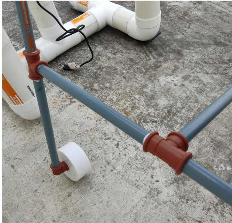
Ensamblado de las tuberías y accesorios de la red de distribución
