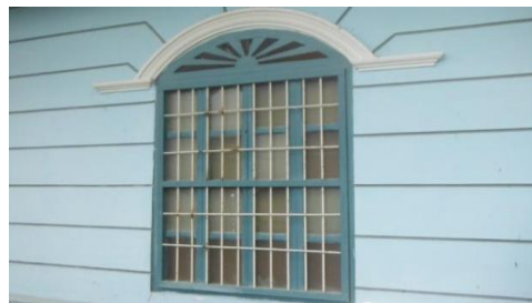
Figura A5 14. Ventanas del edificio administrativo
