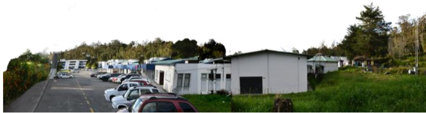
Figura A5 23. Panorámica externa al edificio administrativo parte derecha
