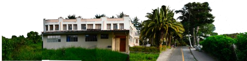
Figura A5 24. Panorámica externa al edificio administrativo parte izquierda
