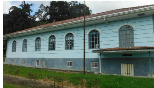
Figura A5 11. Fachada parte izquierda del edificio administrativo
