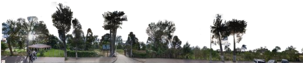
Figura A5 22. Panorámica externa al edificio administrativo parte frontal
