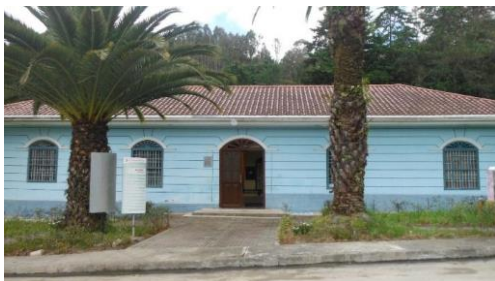
Figura A5 8. Fachada frontal del edificio administrativo
