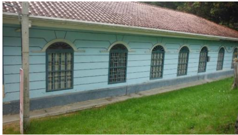
Figura A5 12. Fachada parte derecha del edificio administrativo
