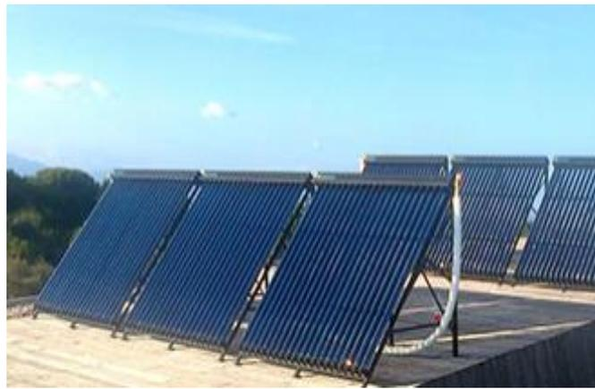
**Figura 4.** *Colector solar de tubos de vacío de flujo directo.*
