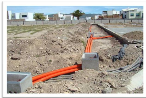
Figura 2. Sistema de distribución subterráneas. n. Fuente. (Pinterest, s.f.)
