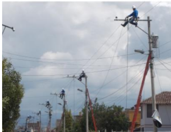
Figura 1. Sistemas de distribución aérea. n. Fuente: (LyRec, s.f.)
