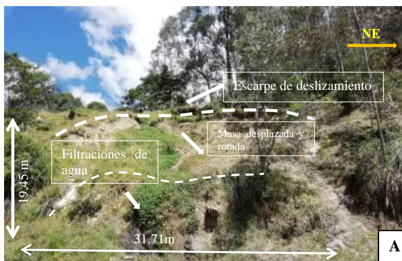
Figura 45. Depósito de Deslizamiento 04. Comunidad Ilincho.
