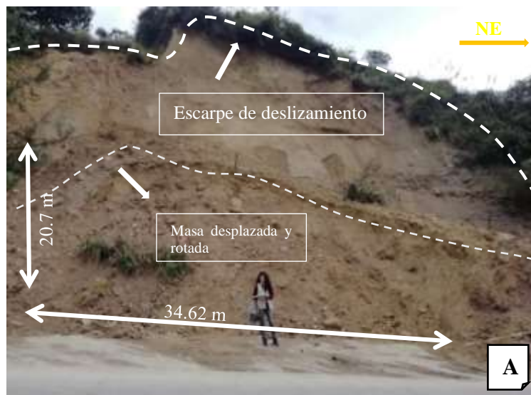
Figura 44. Depósito de Deslizamiento 03. Comunidad Ilincho.
