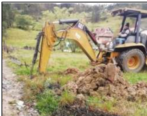
Figura 27. Excavación de calicatas, en el sector de estudio.
