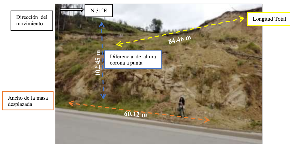
Figura 28. Descripción de deslizamientos.
