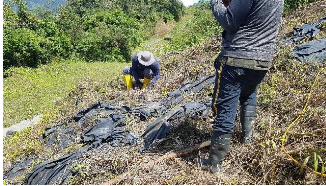
Figura 32. Zona de acumulación al pie del talud de Ventana 4
