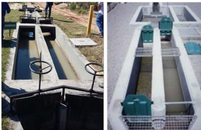
Figura 5. Canales desarenadores.
