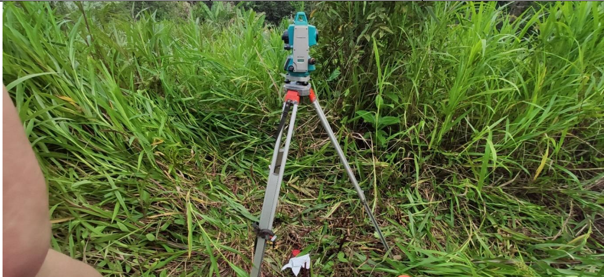
Foto 16. Montaje realizado de la estación total.
