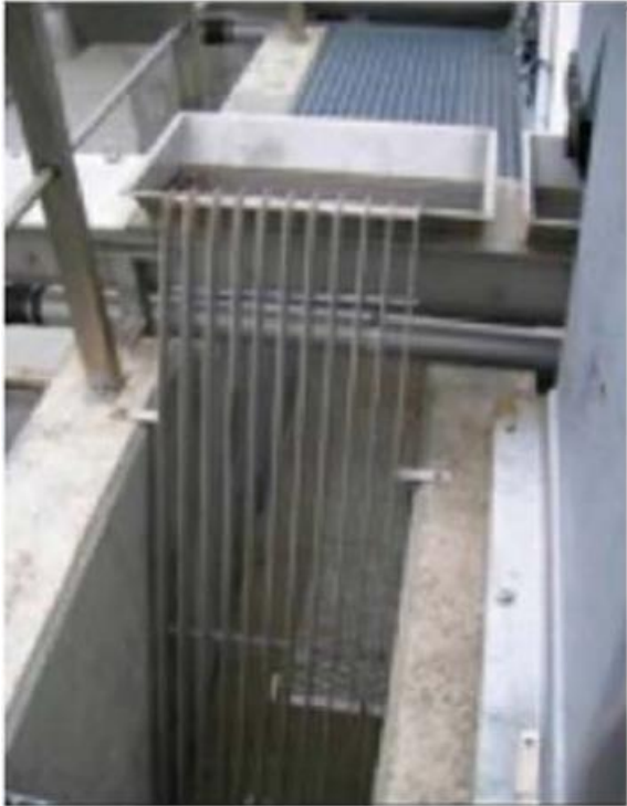
Figura 2. Reja de desbaste de limpieza manual.
