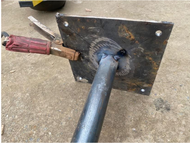
Figura 25. Base unida al tronco del árbol
