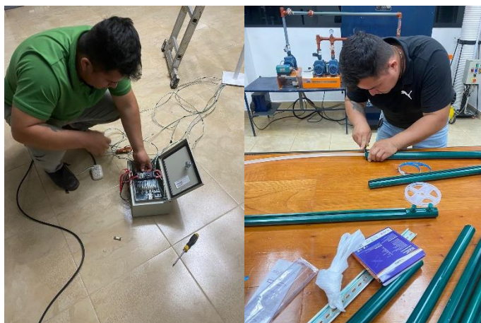
Figura 29. Instalación del sistema de iluminación y sistema de control eléctrico
