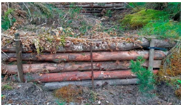
Diques de contención
