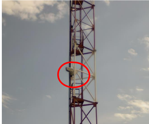
Figura 40. Instalación FSO en Siria 3.5 Km
