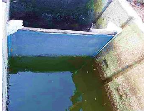
FIGURA N°9.- Cierre de compuertas
