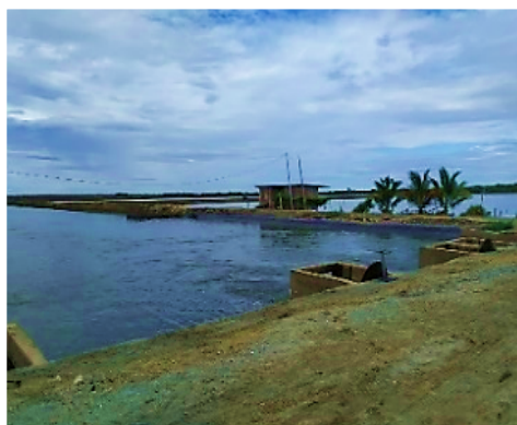
FIGURA N°14.- Bombeo de agua: una vez ya desinfectada y fertilizada la piscina se abren las compuertas para llenar las piscinas aprovechando el agujaje del estero salado.
