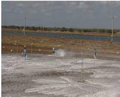
FIGURA N°12.- Colocación de Cal P-24
