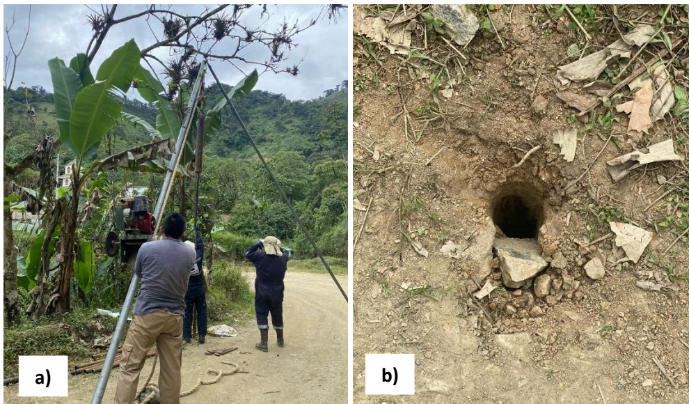
Figura 19 Trabajo en campo de ensayos de penetración estándar.
