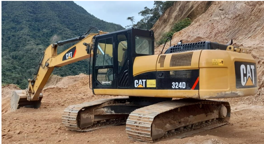
Figura 39 Excavadora Caterpillar 324D LN
