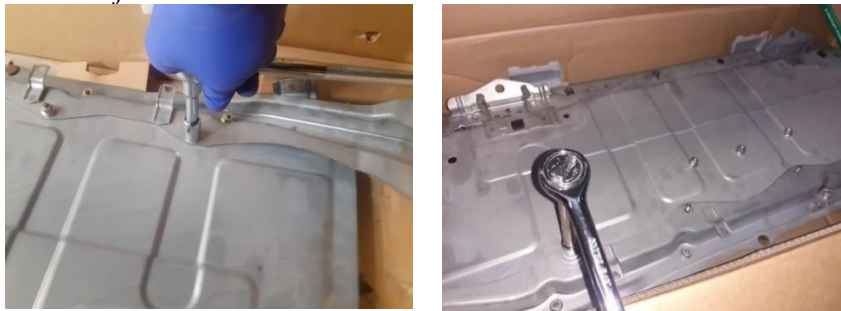
Desmontaje de chasis inferior
