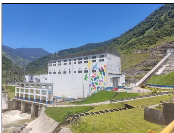
Casa de Máquinas de la Central Hidroeléctrica Delsitanisagua.
