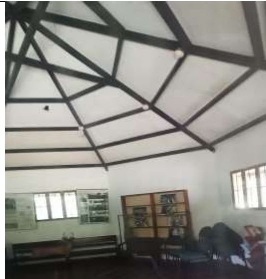
Infraestructura de residencia del guarda parques.
