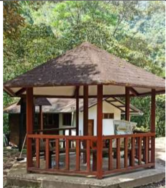
Cabaña para uso de los visitantes ubicada en el centro administrativo.
