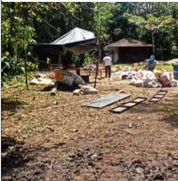
Construcción de una cabaña en el centro administrativo.
