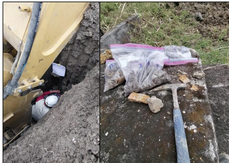
Figura 47. Excavación y recolección de muestras en la trinchera 3
