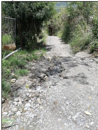
Figura 37. Infraestructura vial de San José de las Peñas
