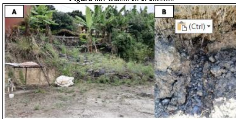
Figura 83: Daños en el entorno
