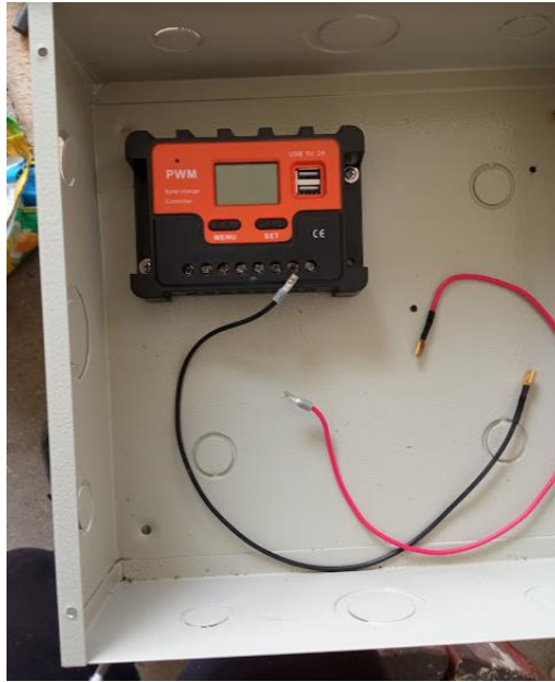
Figura 45. Colocación del inversor solar en la caja metálicas.
