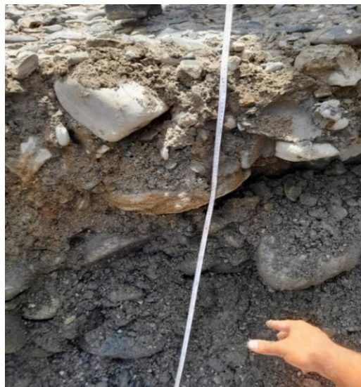
Figura 16. Calicata 2 Fuente: el Autor (2022)
