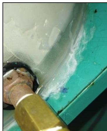
Figura 27. Aplicación de EPOXI (tanque de descarga). Fuente. El autor.
