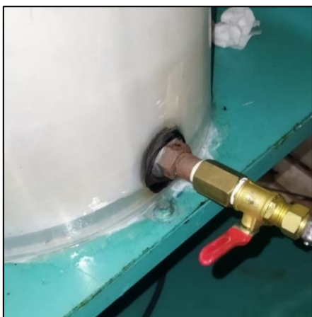
Figura 26. Válvula tipo bola reguladora para descarga. Fuente. El autor.
