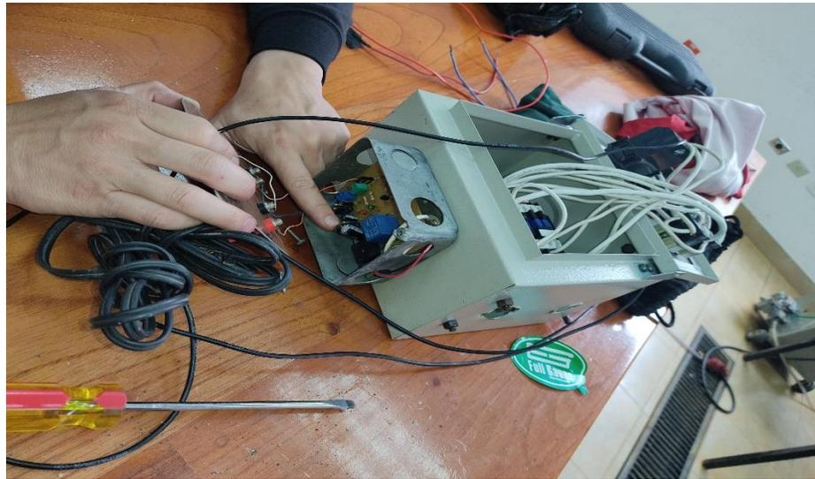
Caja de control eléctrico sin señalética y cableado eléctrico en desorden.
