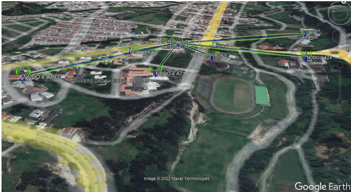
Figura 19. Enlace LoRaWAN Nodos ambientales, UNL Matriz Barrio La Argelia.
