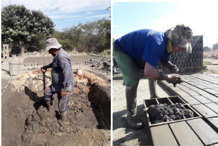
*Figura 9.* Tillaguango, K. (2021). Proceso de elaboración de ladrillos [Fotografía]
