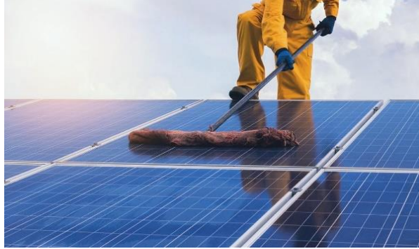
Ilustración 29: Limpieza de un panel fotovoltaico | Fuente: Guía de operación y mantenimiento de sistemas fotovoltaicos. Ministerio de energía. Gobierno de Chile [45].
