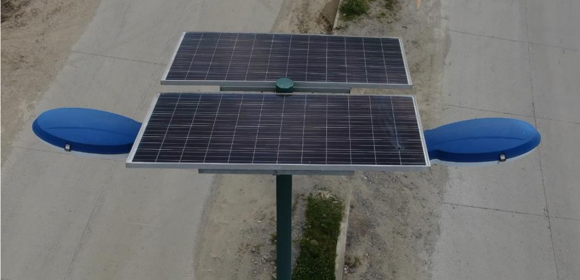
Ilustración 34: Vista aérea con dron de los paneles solares cubiertos con suciedad. | Fuente: Autores
