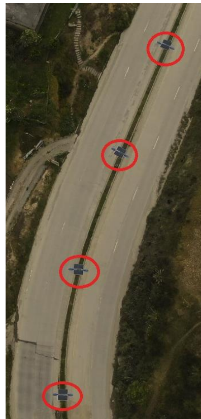
Ilustración 13: Vista aérea de la instalación de los postes con sistemas fotovoltaicos autónomos. | Fuente: Autores
