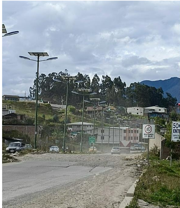
Ilustración 14: Estado actual de los paneles fotovoltaicos funcionando en presencia de polvo. | Fuente: Autores
