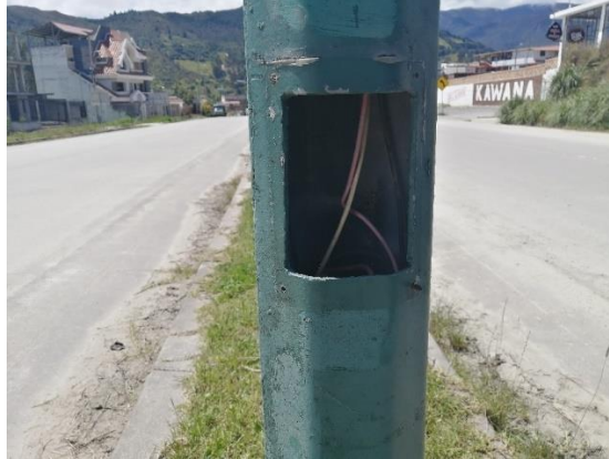
Ilustración 27: Poste al cual se le ha sustraído su regulador de carga. | Fuente: Autores.
