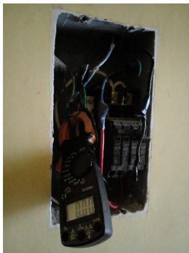
Figura 55. Medición de corrientes de fuga sin carga conectada
