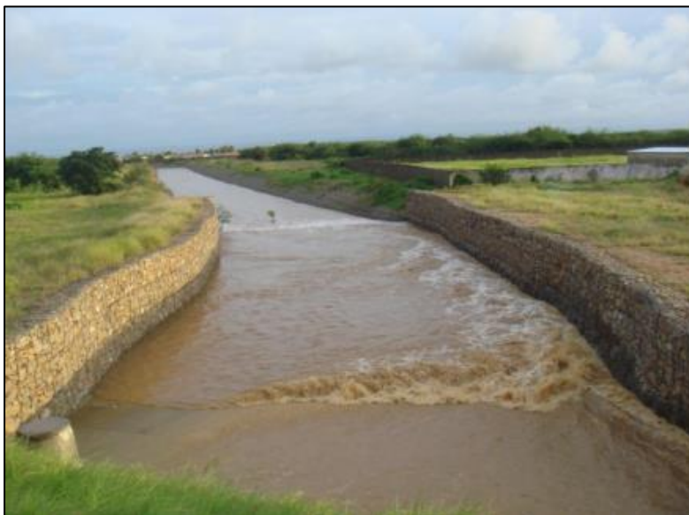
Dique marginal encausamiento de un río
