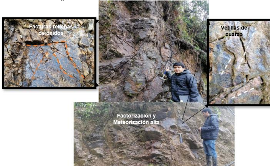
Figura 14. Andesita afanítica fracturada con oxidación
