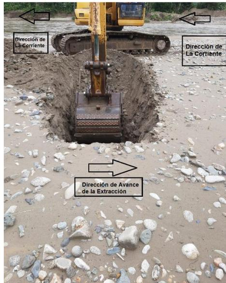
**Figura 34.** Extracción de áridos y pétreos en dirección corriente arriba al cauce natural
