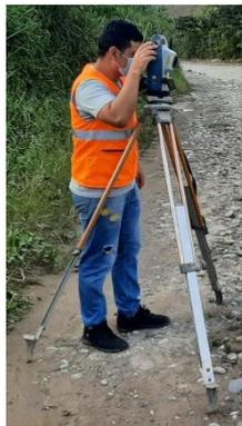
**Fotografía 1.** Levantamiento topográfico del lugar de estudio
