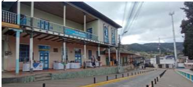
Figura 14. Vista diagonal del ITUR Vista de la entrada al ITUR desde el parque central.
