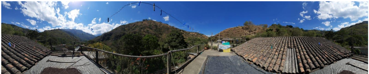
Figura 38. Inspección del lugar
