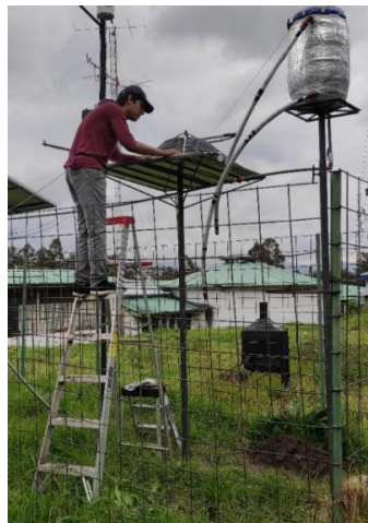
Figura 24. Instalación de los componentes del calentador solar.
