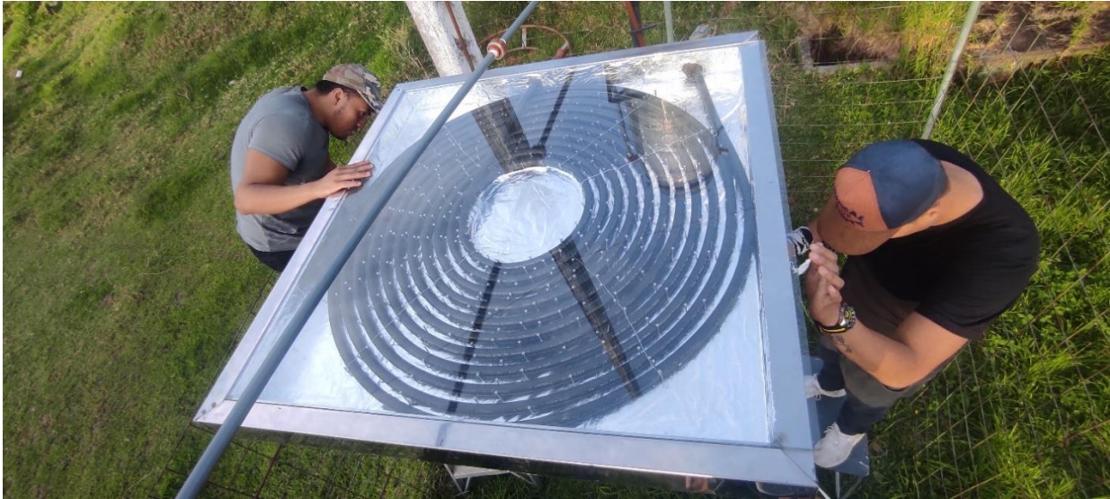
Figura 39. Instalación del colector solar.
