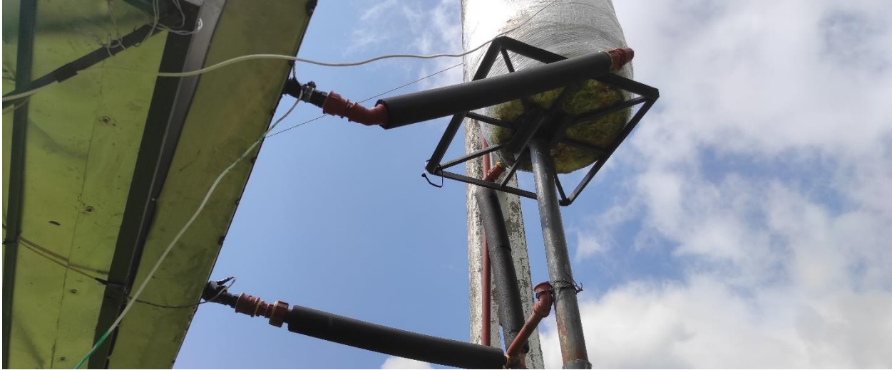
Figura 41. Conexión de tuberías PVC de agua caliente y agua fría.
