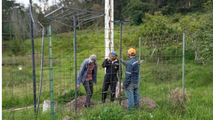
Figura 23. Adecuación de la estructura de soporte del calentador solar.
